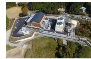
地熱発電事業：大岳発電所
