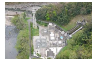
水力発電事業：新竹田発電所
