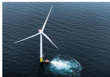
写真提供：Vestas Wind Systems A/S
