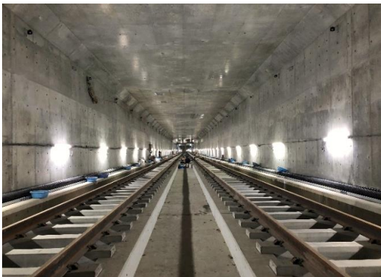
▲綱島トンネル
