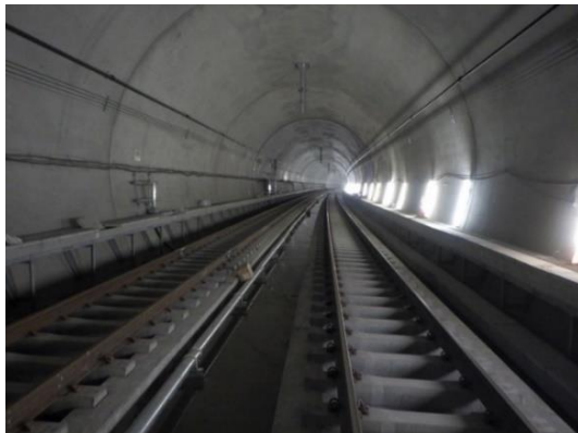
▲羽沢トンネル
