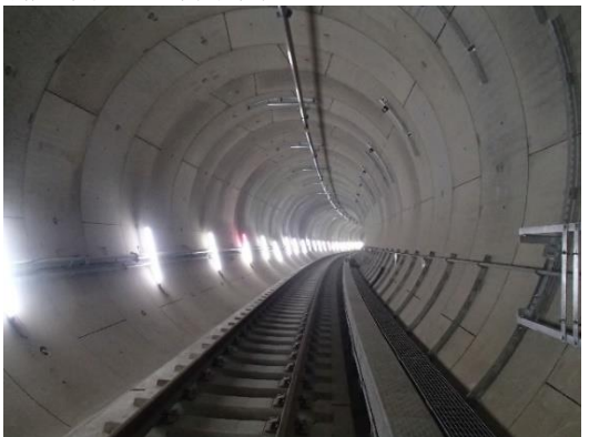
▲綱島トンネル
