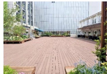
[A 館 3 階屋外スペース「GREENING 広場」]
