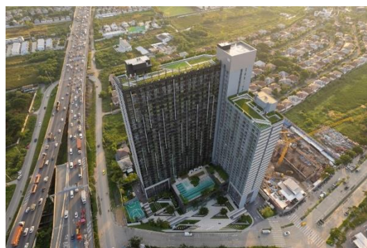
完成写真 (タワー1)
